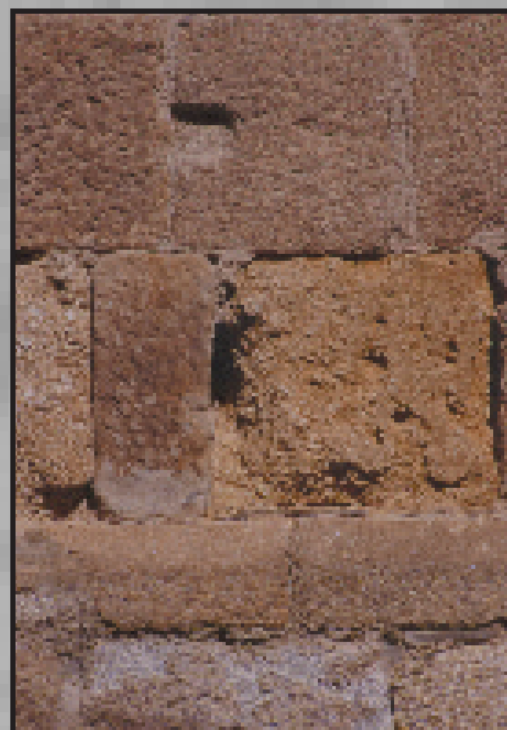
27. Santa Maria de Riquer (Cattlà) La façade est en belles pierres de taille de granites variés. Les granites grossiers (renfermant de la biotite et de grands cristaux de feldspath blancs, au centre-droit de l'image) sont plus altérables que les leucogranites (à petites muscovites) à grain fin.
