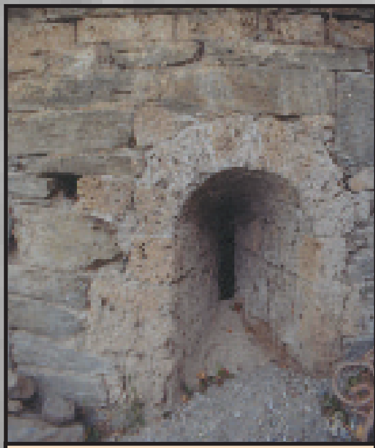
53. Sant Marti (Noedes) Le mur de l'abside est en grandes pierres de schistes gris-vert pris sur place. La fenêtre, très ébrasée, est en travertin. Ce travertin provient de l'autre côté de la vallée, juste en face du village : il est produit au niveau de sources par l'eau qui a percolé à travers les calcaires du massif du Coronat.
