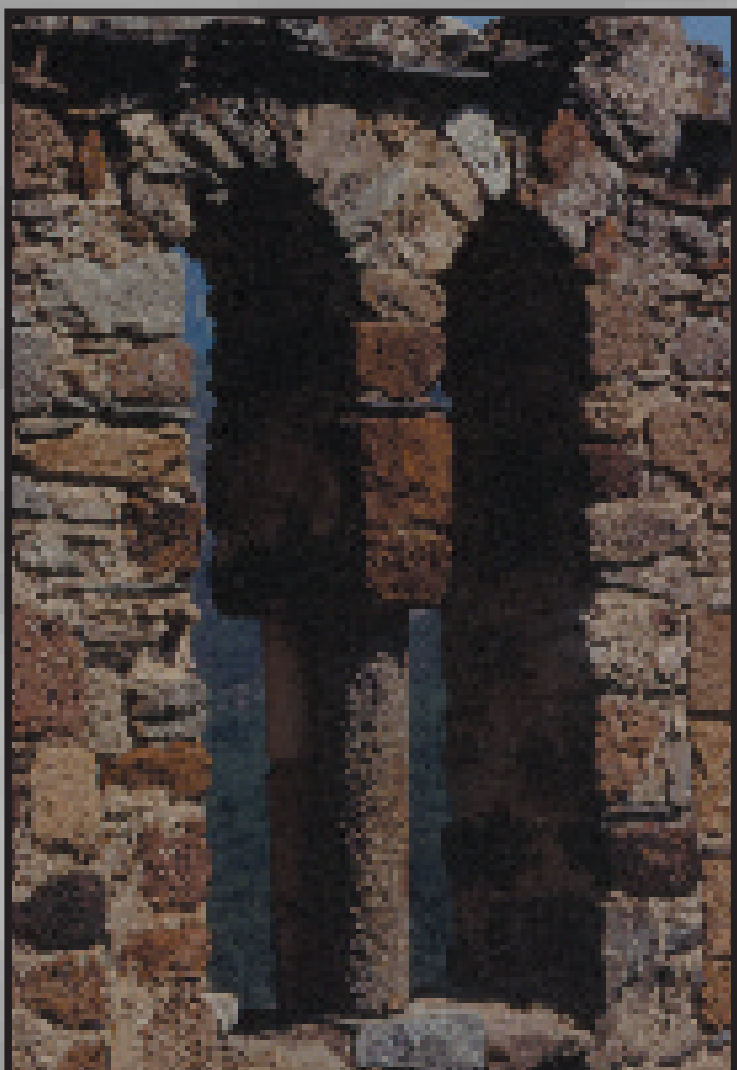
74. Santa Creu de Torèn (Saorra) A deux pas des anciennes mines de fer d'Escaró, la petite église de Torèn frappe le regard par la présence de nombreux blocs, plus ou moins taillés, de minerai de fer rouge brique à ocre rouge, mêlés à des blocs de marbre, de micaschiste, de travertin...
