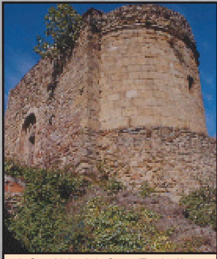
45. Sant Valenti de Corts (Taurinyà) L'église primitive (XI e siècle) était entièrement construite en blocs et moellons de marbres, de gneiss, de schistes et de minéral de fer, le tout de provenance très locale (l'église, tout comme celle d'En, étant bâtie sur un rocher de marbre dolomitique). L'abside a été reconstruite (au XII e siècle) en grand appareil de leucogranite à patine jaune soigneusement taillé, avant d'être surélevée (fortifiée ?) par un mur à nouveau fait de matériaux pris sur place...
