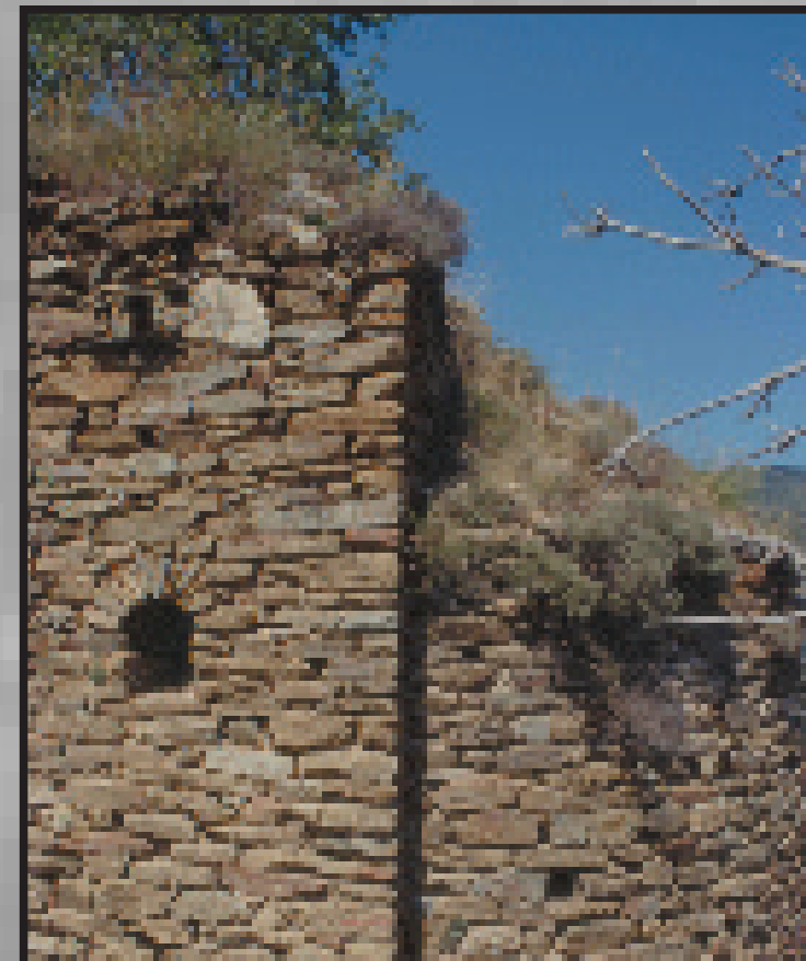
97. Sant Joan d'Entrevalls (Toès) L'église est entièrement construite en moellons d'une roche d'aspect schisteux mais claire et très dure : il s'agit en fait d'une mylonite (roche "laminée" par une déformation très intense) de granites, mais aussi de gneiss et de micaschistes.
