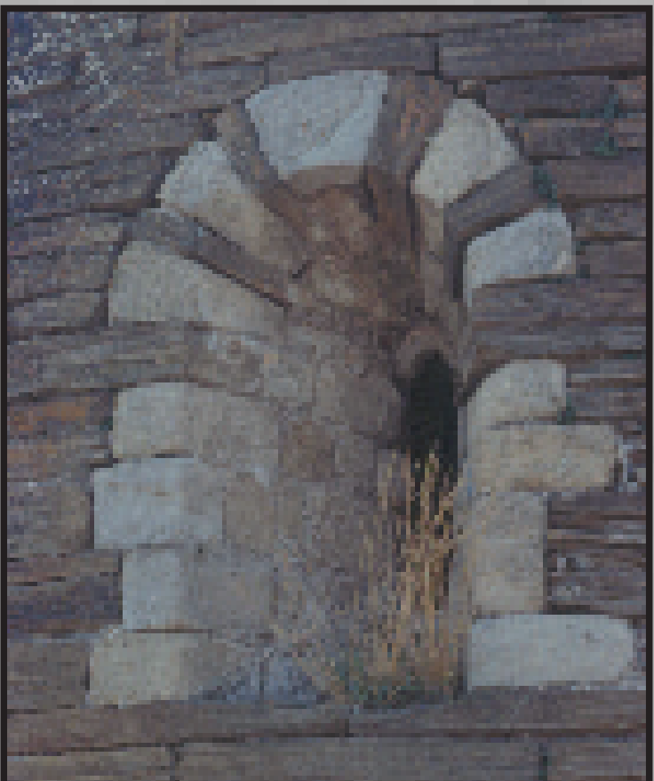
52. Santa Margarida de Nabilles (Conat) Les murs, très bien assisés, sont faits de belles dalles de schistes rubanés verdâtres à patine ocre soigneusement taillées. Dans l'arc de la fenêtre de l'abside, aussi simple qu'élégante, le granite blanc se mêle au schiste sombre ; il forme à lui seul les piédroits.
