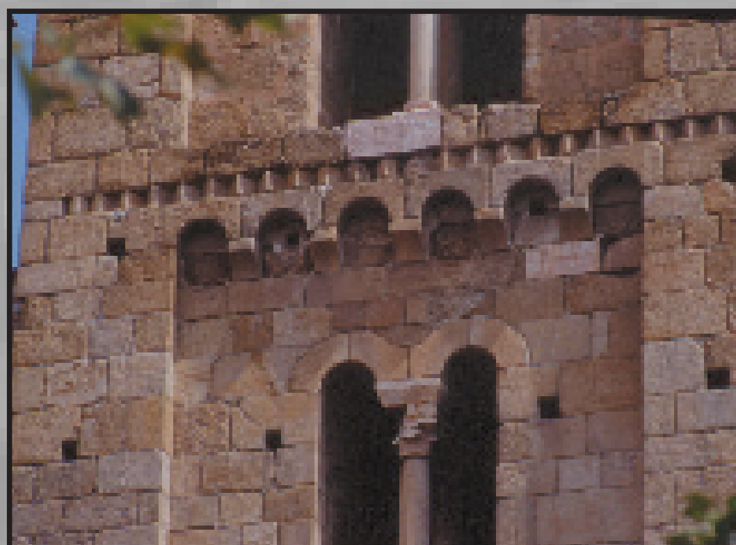
24. Sant Pere (Prada) Ce très beau clocher est en grand appareil de leucogranite à patine ocre, principalement, plus accessoirement de gneiss ocellés plus sombres et aussi plus altérés et de « marbre » rose et blanc de Villefranche. La provenance des leucogranites de ce type n'est pas clairement établie : massif du Canigou ou massifs granitiques situés au nord de la Tet ?
