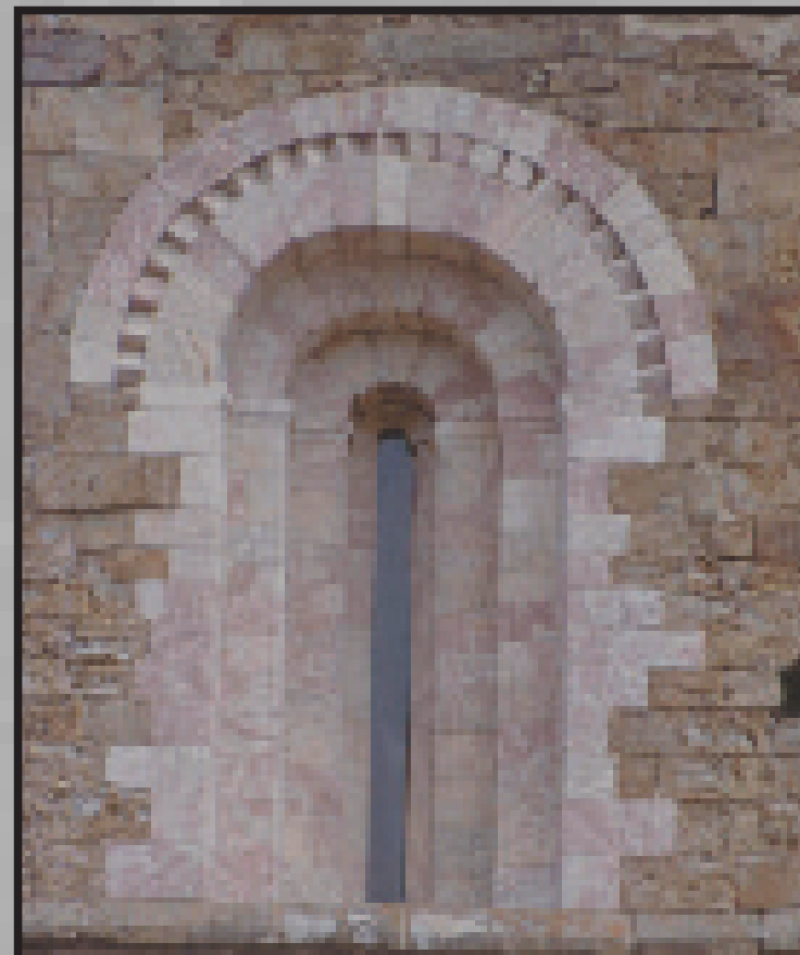
5. Santa Maria de Marcèvol (Arboçols) Très belle fenêtre (et haut du portail) en « marbre » de Villefranche rose et blanc. Le mur de la façade est fait d'une roche vacuolaire ocre orangé à gris-vert peu courante (probablement des cornéennes altérées dans le granite, juste après sa mise en place) affleurant aux environs immédiats de l'édifice.
