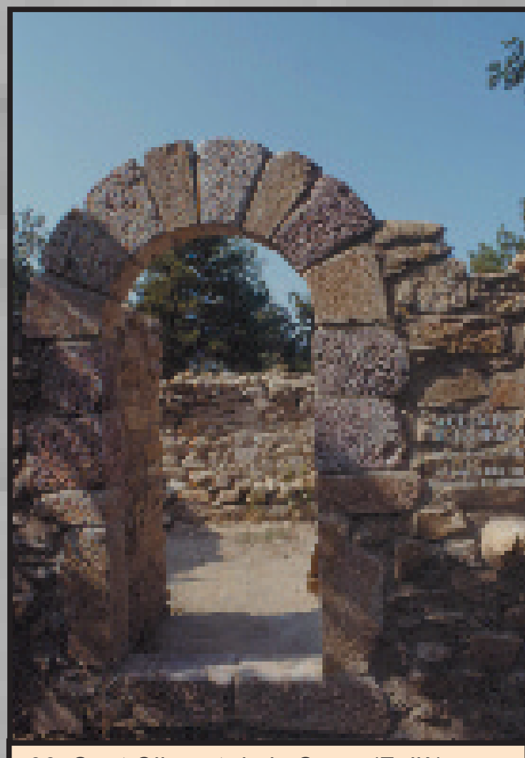
66. Sant Climent de la Serra (Fullà) La reconstruction d'une porte en calcaire dévoniens roses, blancs et jaunes semble un parti discutable pour cette petite église dont les murs (du moins ce qu'il en reste...) datent peut-être du X e siècle et sont faits de blocs de gneiss caillés empruntés aux alluvions miocènes sur lesquelles s'élevait l'édifice.
