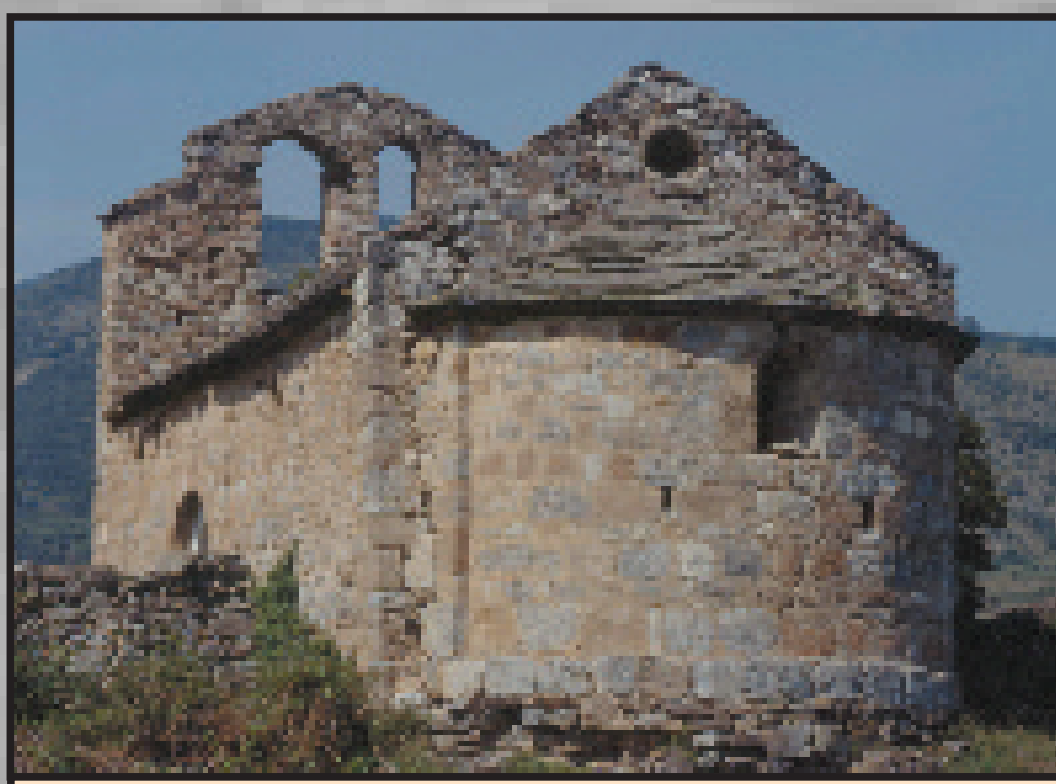
87. Sant Just i Sant Pastor d'En (Nyer) Simple mais parfaite petite église du XII e siècle, entièrement en marbre blanc-bleu (marbre calcaire) ou ocre (marbre dolomitique). Le second provient du rocher sur lequel est construite l'église (les désordres visibles dans le mur de l'abside sont à mettre en relation avec cette situation), tandis que le marbre blanc-bleu peut provenir des environs du hameau d'En, à quelques centaines de mètres de là.
